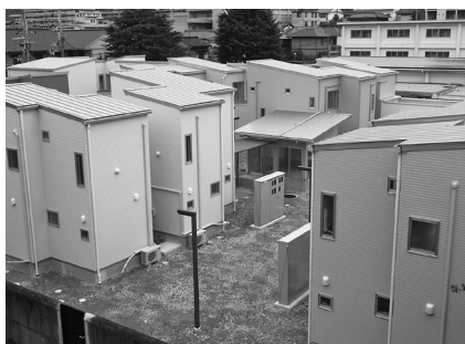
【S棟の外観】
